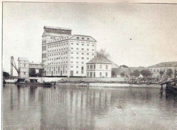
Áruraktár és elevátor. — Warenlager und Lift. — Dépôt de marchandises et ascenseur. Warehouse and elevator.
