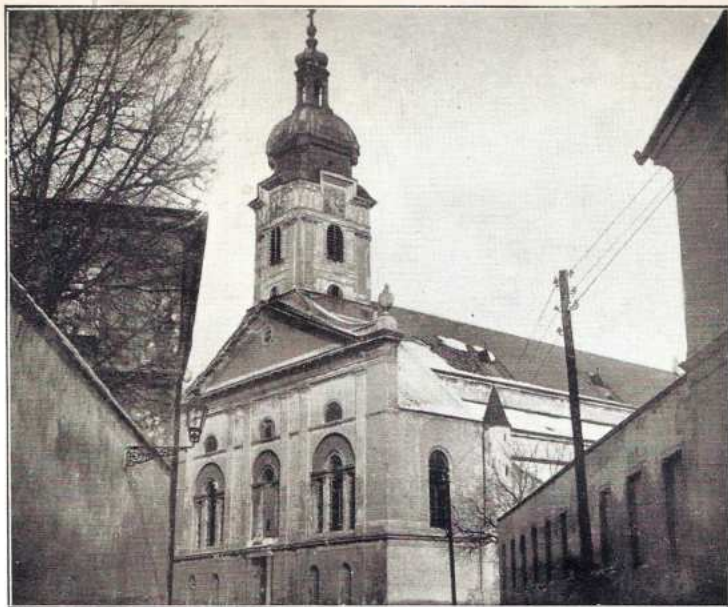
Győri székesegyház. — Die Kathedrale von Győr. — La cathédrale de Győr. The cathedral of Győr.
