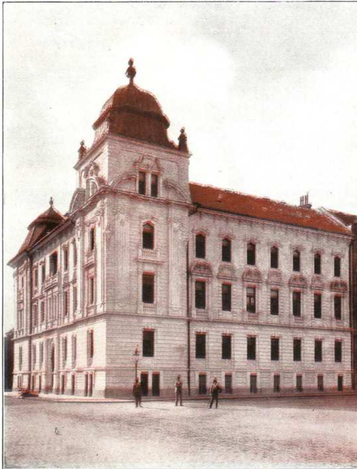
A Rábaszabályozó Társulat győri székháza. — Sitz der Rába-Regulierungs-Gesellschaft. — Siège du Syndicat pour Régularisation de la Rába. — House of the Rába Regulation Co.
