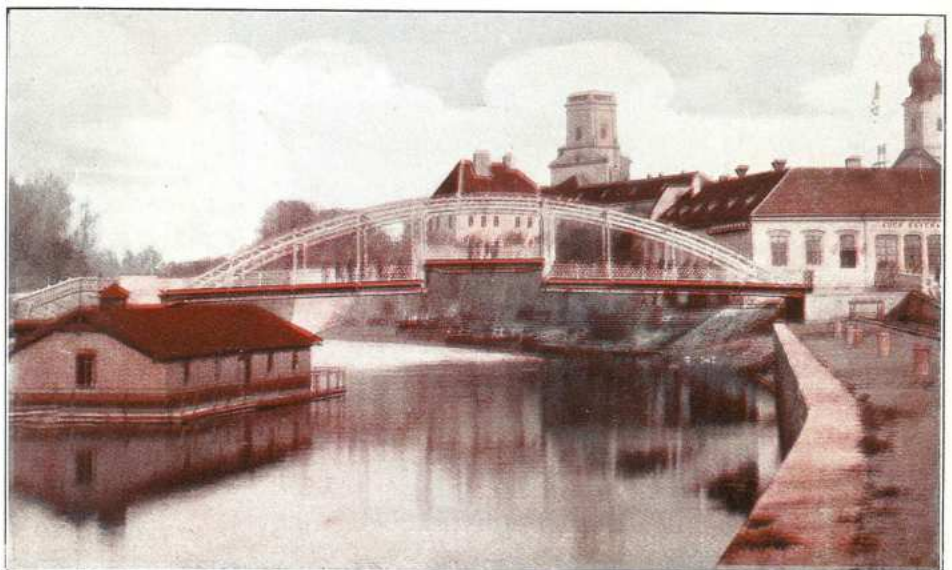
A Rába-híd nyitva. — Die Raab-Brücke, geöffnet. — Le pont sur la Raab, ouvert. — The bridge over the Rába, open.
