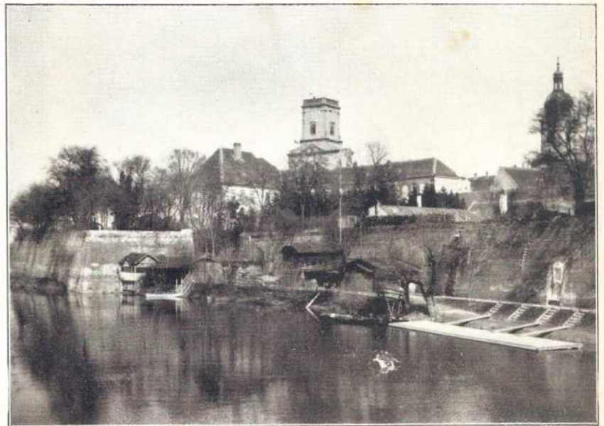
A Győri Tornaegylet csónakháza a püspökvár bástyáinak tövében. — Die Boothäuser des Raaber Turnvereines an der Bastei der Bischofsburg. — Huttes de canotage de l'association de gymnastique de Győr sous les bastions du chateau episcopal. — The Boathouses of the gymnastic society of Győr at the foot of the ramparts of the episcopal castle.
