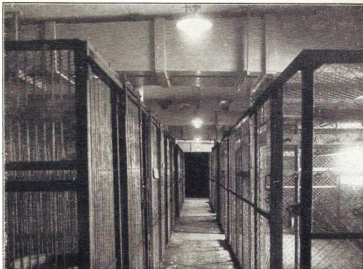
Hűtő. — Kühlhaus. — Établissement réfrigérant. — Refrigeratory.
