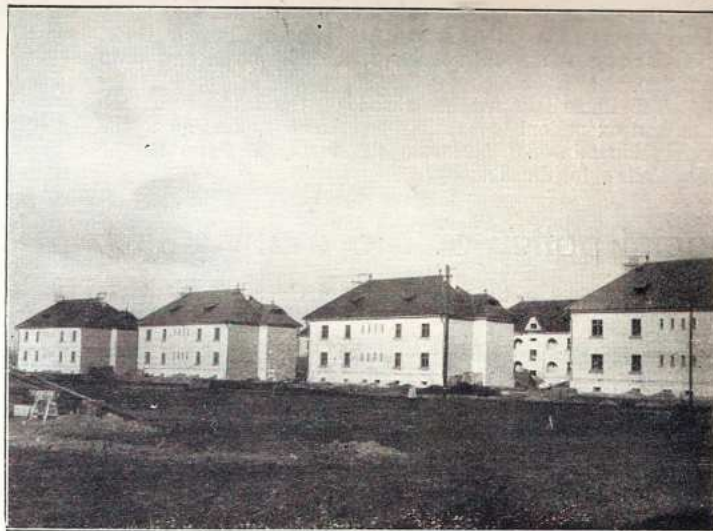
Részlet az épülő városi bérháztelepről. — Teilansicht der in Bau stehenden städtischen Miethäuser. — Vue partielle des maisons de louage de la ville en construction. — Partial view of the towns rent-houses being built.
